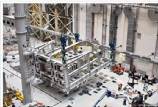
図3 TF12の立て起こし作業
