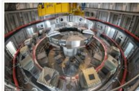
図1 PF6ピット内仮設置
