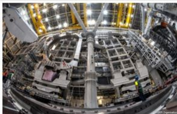
図4 TF12のSSATへの仮設置
